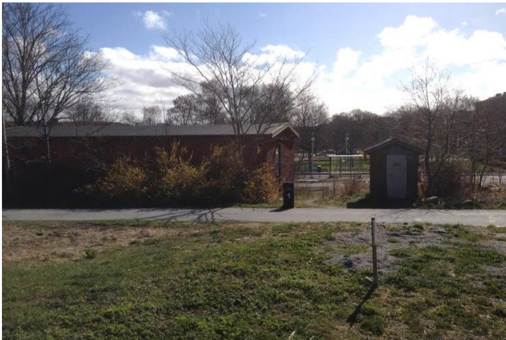
Figur 2 Översikt, bild tagen åt sydost från Kyrkbyn 38:5, mot transformatorstationen och ställverket på Kyrkbyn 38:2.
